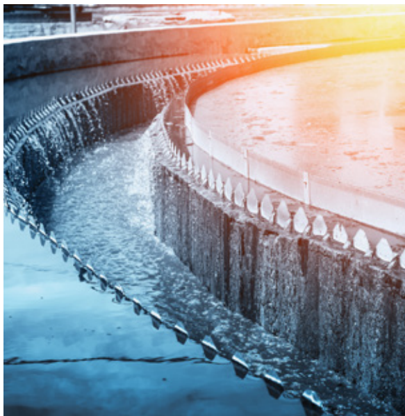
Vann er en viktig ingrediens i produksjonen av keramiske fliser, og ved å filtrere og rense vannet etter bruk kan opp til 100% av vannet gjenbrukes.
